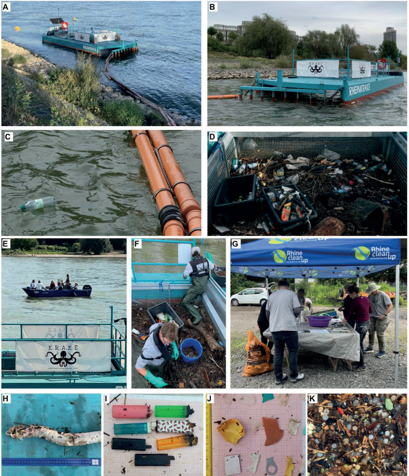
Abbildung 2: A) RheinKrake (RK) mit Leitfangzaun, der mit dem Ufer verbunden ist. B) Eingang der RK mit Rechen, die große Äste und Bäume zurückhalten. C) Der Leitfangzaun leitet MA zum Eingang der RK. D) Die RK ist sehr voll und ein Teil der Makroabfälle (MA) befindet sich bereits in den Auffangkörben (Bildnachweis: Simon Taal). E) Die RK wird alle zwei Wochen mit einem Boot angefahren, um sie zu reinigen und Proben zu entnehmen (Bildnachweis: Thorsten Kniewel). F) Freiwillige tragen Wathosen, um den MA aus dem Korb zu holen und in Plastikboxen zu sammeln. Totes Holz und nicht anthropogene Abfälle wurden während der Reinigung entfernt und nicht zum Auswertungsort transportiert. G) Nachdem der MA an Land transportiert wurde, sortieren und kategorisieren Freiwillige jeden Gegenstand mit Hilfe einer speziell entwickelten App. H) Tote und lebende Tiere werden ebenfalls gemessen und überwacht. I) Feuerzeuge sind ein häufig vorkommender MA-Gegenstand, der leicht zu identifizieren ist. J) Nicht geschäumte Kunststofffragmente sind die dritthäufigste Kategorie, die im Rhein gefunden wird. K) Auch wenn Gegenstände <3,818 cm nicht systematisch zurückgehalten werden, findet man oft kleine Abfälle wie Kunststoffgranulat in der RK.
